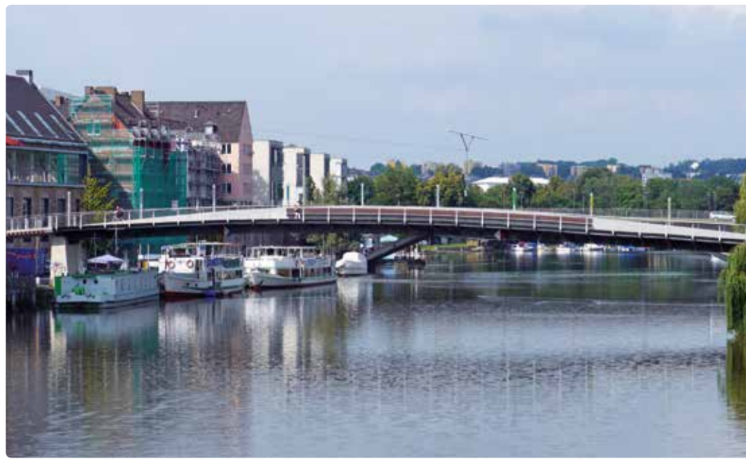
Die Karl-Branner-Brücke verbindet die Unterneustadt mit der Innenstadt
